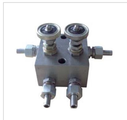
图示左侧两个管接头与电磁阀箱接管相连，上下两管接头与液压执行机构相连，右侧两单向管接头可在急情况下接手动泵。使用手动泵时，关闭应急阀块上两截止阀，这时可通过操作手动泵组控制液压执行机构，从而控制阀门的开或关。
